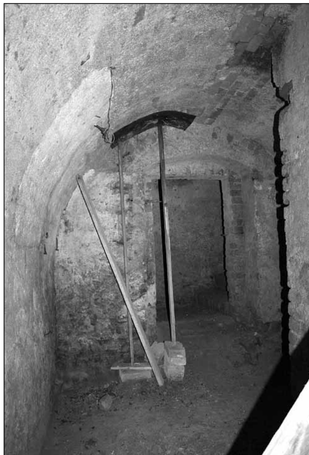
Suterénní místnost s klenbou podepřenou pilíři jako statickým řešením při vestavbě střední chodby koncem 40. let 19. století, foto, 2008.
