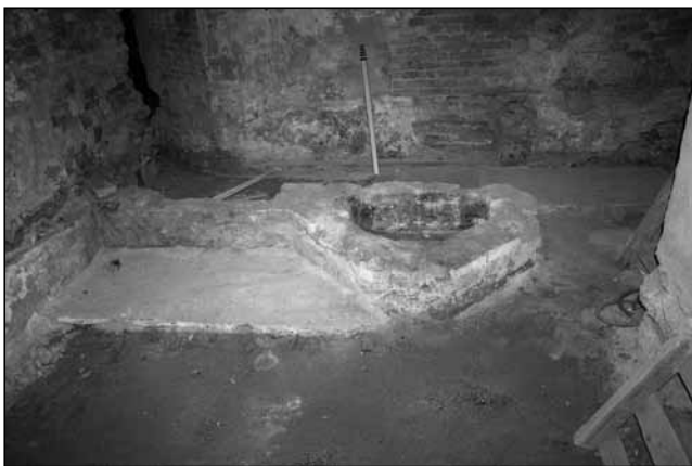
Základ zdi chodby se společným topeništěm pro dvě cely v místnosti 106, foto, 2008.
