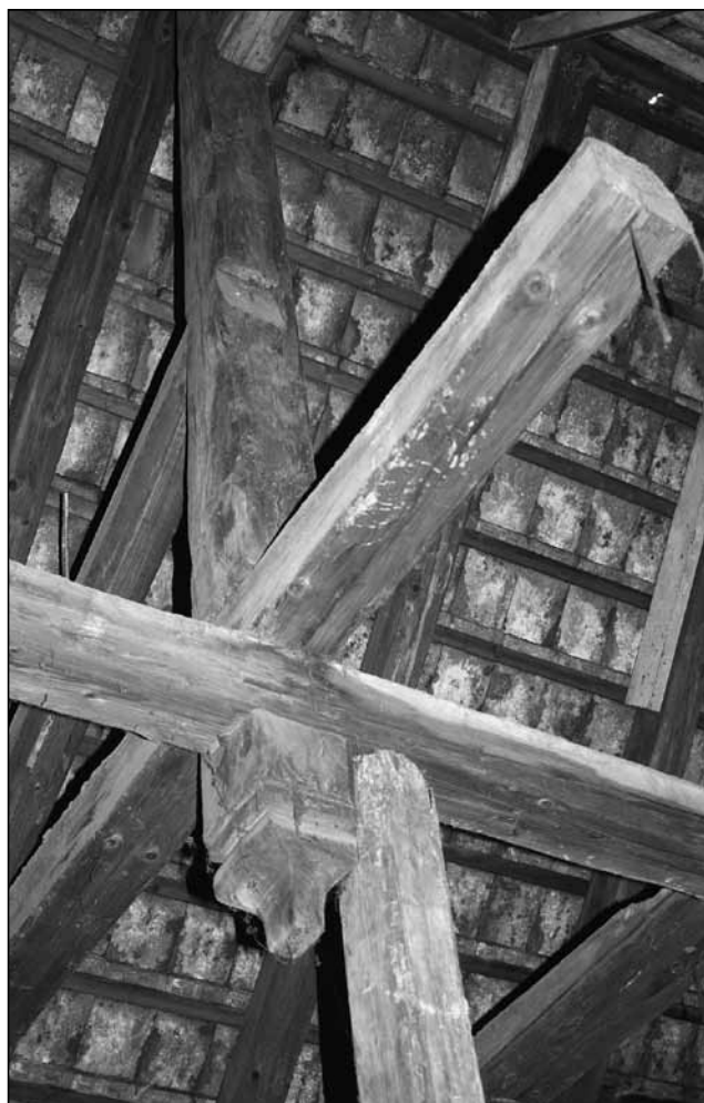
Detail vazby krovu s ozdobně vyřezávaným věšákem, druhotně provizorně podepřený sloupkem, foto, 2008.
