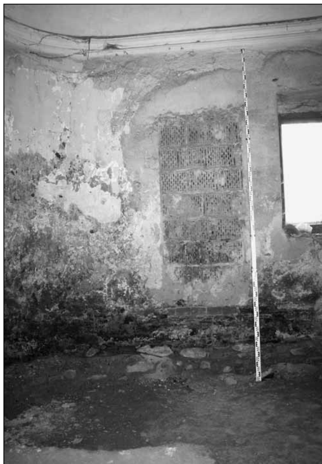
Východní zaoblený roh v kapli 105 s oknem zazděným tvárniciemi, foto, 2008.
