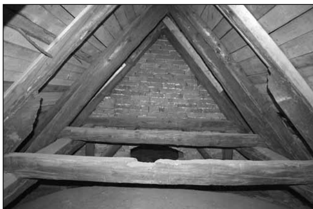
Krov kaple se seříznutými krokviemi jako stopa po věži, foto, 2008.
