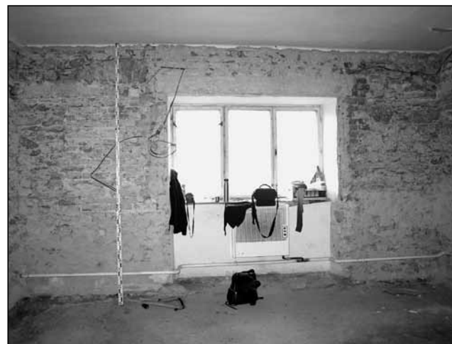
Jihozápadní stěna místnosti 102 se zadržkou historického okna, foto, 2008.
