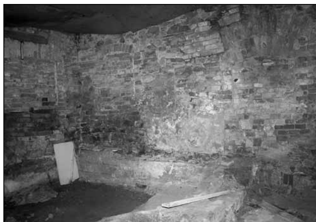
Severovýchodní stěna místnosti 106 se zazdívkami dvou oken, foto, 2008.
